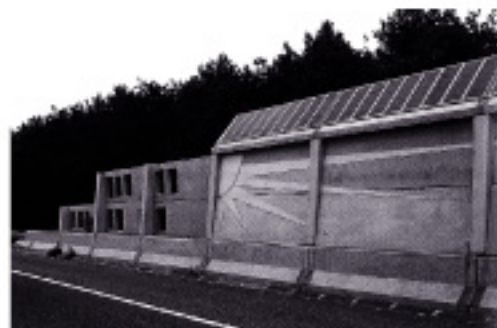
Mur en béton
