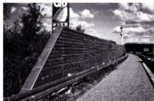
Mur en bois
