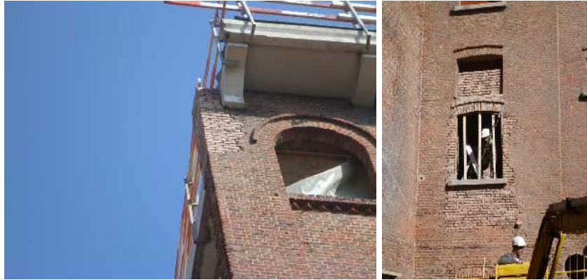
Ragréage de façades à partir de briques de réemploi
