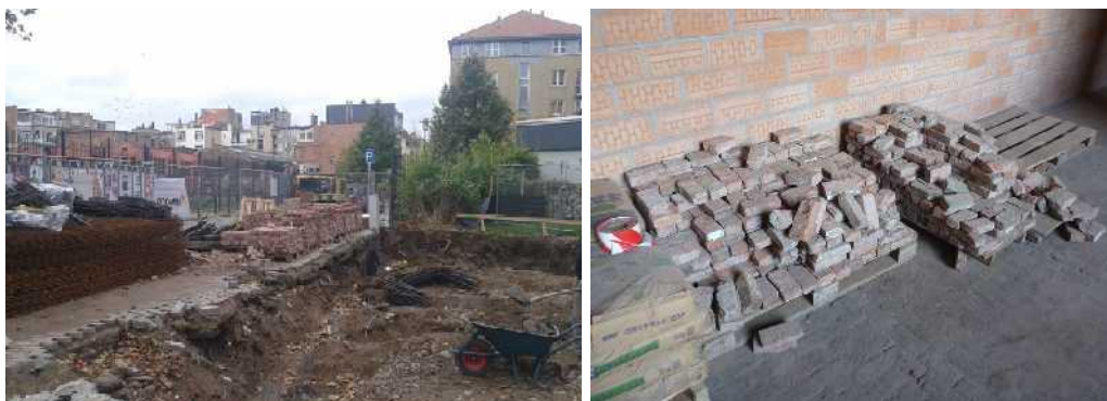
Stockage extérieur et intérieur de briques de réemploi
