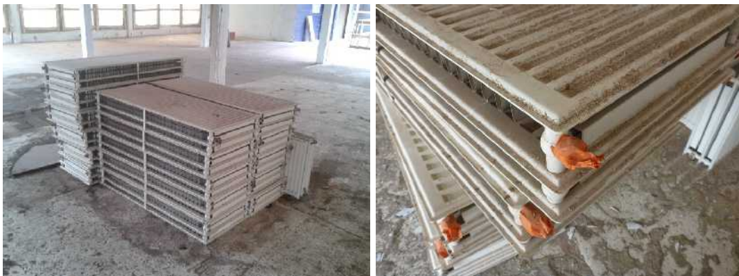
Stockage des radiateurs avec mise en place des « bouchons »
