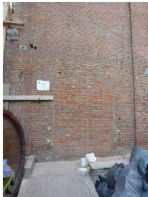
Ragréage d'une façade à partir de briques neuves réalisé lors d'une rénovation précédente
