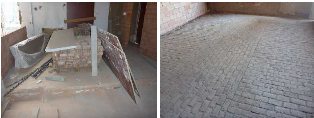
Sol réalisé à partir de briques de réemploi
