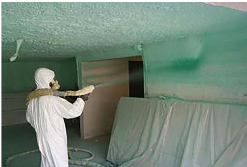
Protection intégrale lors de la mise en œuvre d'un isolant projeté – Source: http://www.renopassive.fr
