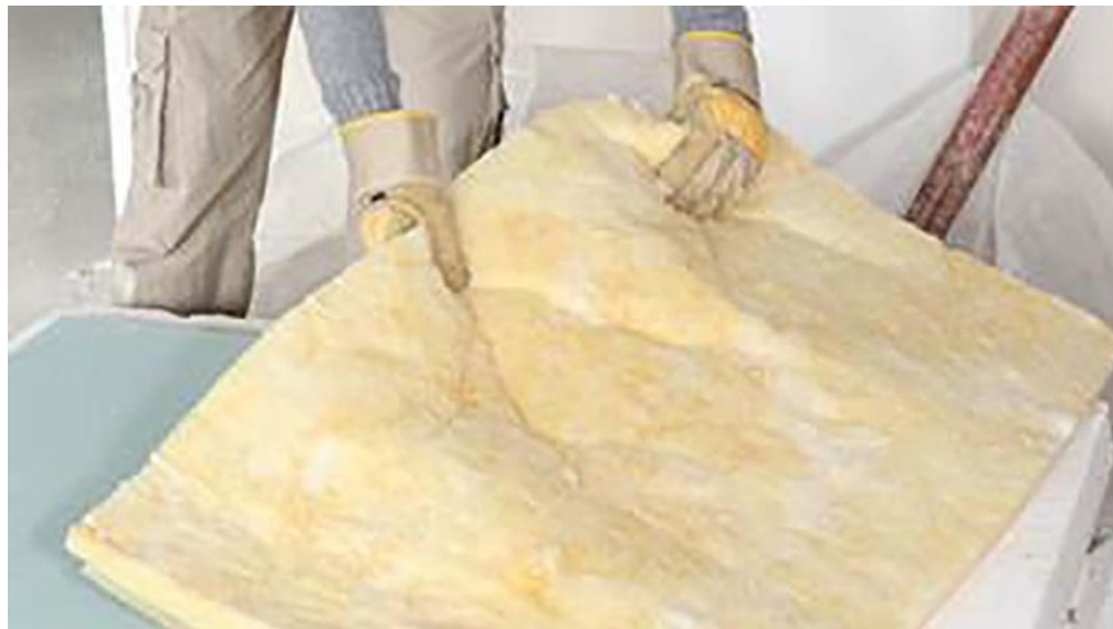
Port de gants lors de la manipulation d'une laine, afin d'éviter l'irritation de la peau. Cette protection est à compléter par un masque lors de la découpe et pose, afin d'éviter l'inhalation de fibres respirables – Source: http://www.renopassive.fr
