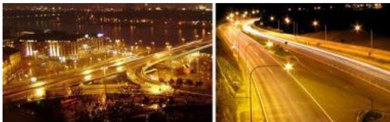
Exemple : Sodium basse pression – Ra ≈ 22
