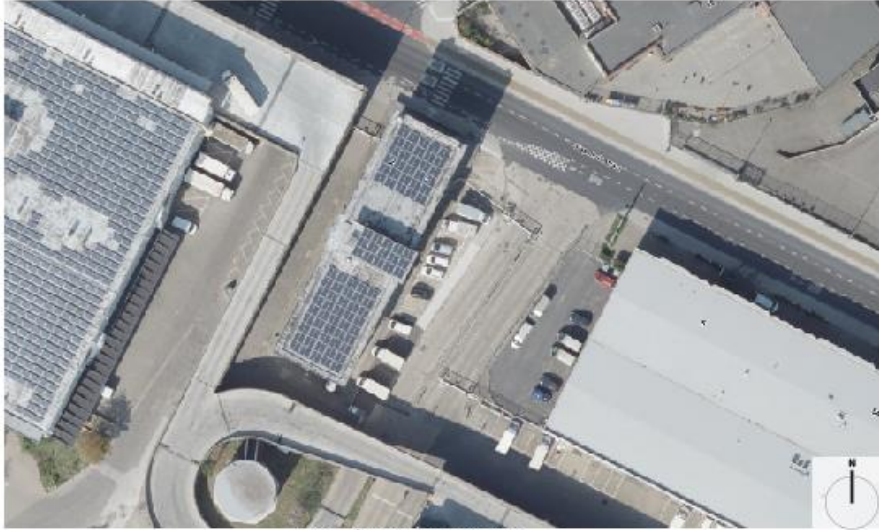
Vue aérienne de la toiture
