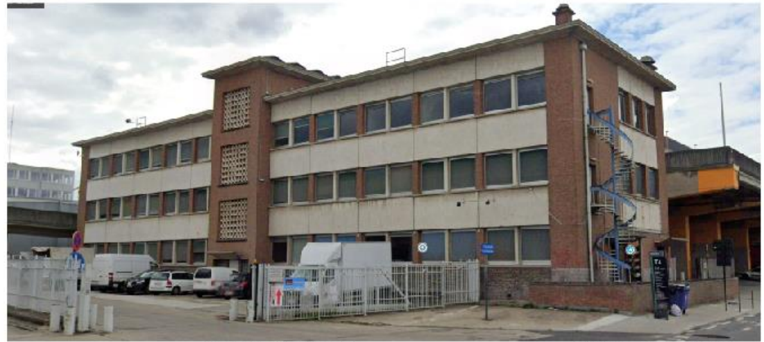
Façade orientée Sud-Est
