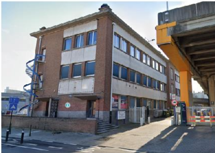
Façade orientée Nord-Est
