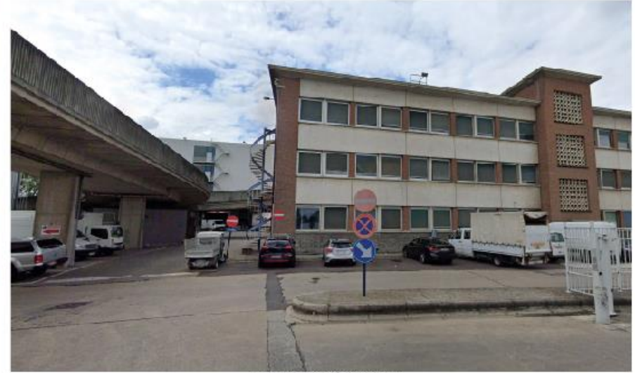
Façade orientée Sud-Est
