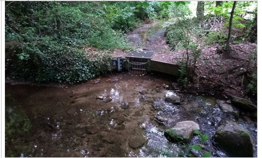
IA10_05. Petite retenue / ouvrage d'art de répartition, d'où l'eau venant du ruisseau se disperse en direction de l'étang.
