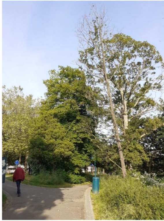
Photo 3 – Erable sycomore n°12235 quasi-mort menaçant les usagers du parc ainsi que l’avenue de Tervuren
