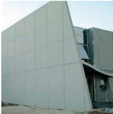
Voile béton armé
