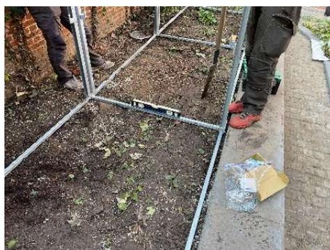
Photo : Mise en place des grilles anti-rats (petite maille), pour lutter contre les indésirables.
