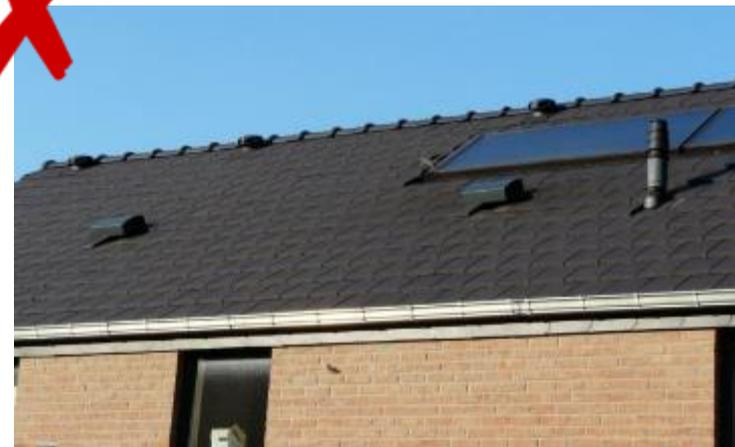
Pour les rejets de ventilation et de chaudière au gaz, une différence de hauteur de 2 m est généralement suffisante
