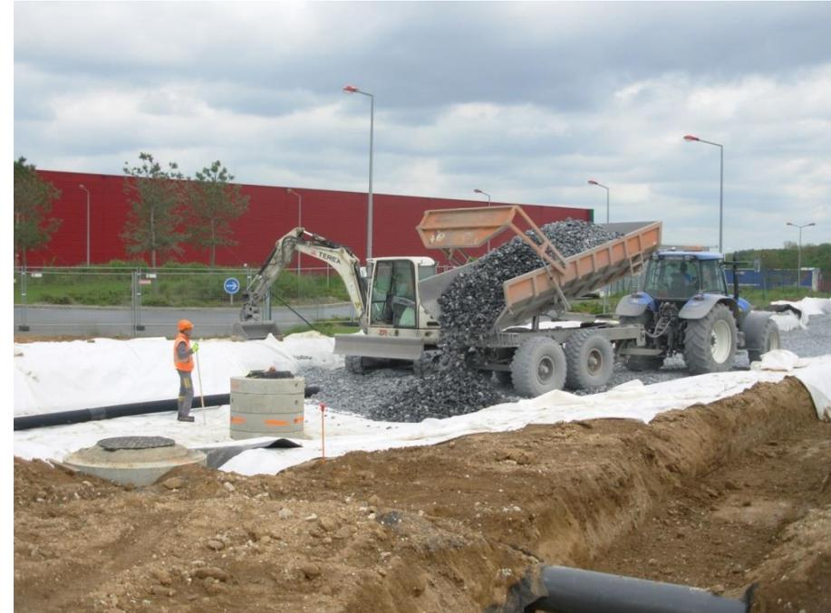
**Chaussée à structure réservoir de rétention avec revêtement classique**
