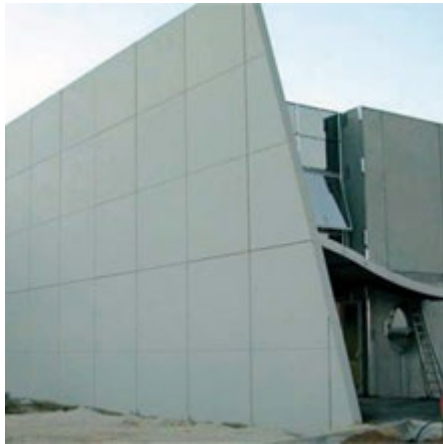
Voile béton armé
