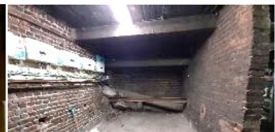
Onduleurs+ compteurs verts et place prévue pour batteries individuelles dans l'espace de l'ancienne citerne
