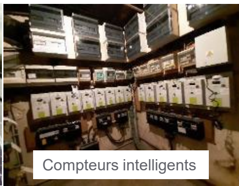
Onduleurs+ compteurs verts et place prévue pour batteries individuelles dans l'espace de l'ancienne citerne
