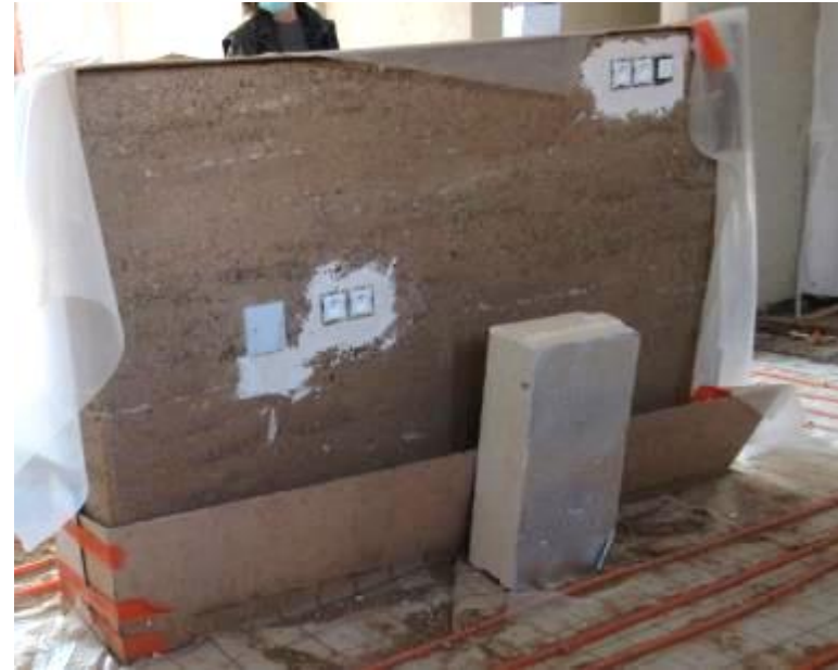
Blochets électriques fixes au plâtre dans le mur en argile
