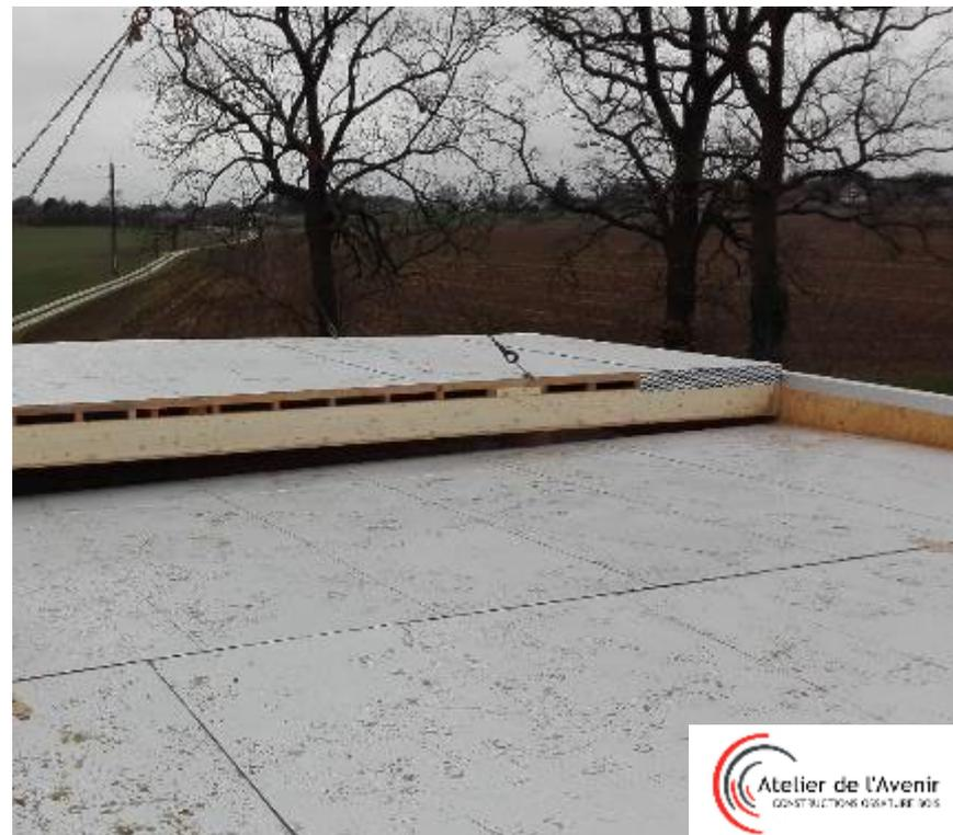
Un pare vapeur autocollant étanche à l'eau permet d'assurer une étanchéité provisoire. La préfabrication de la pente et la pose du pare vapeur en atelier accélèrent la pose de l'étanchéité définitive et la mise hors d'eau du bâtiment.
