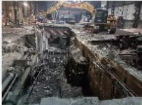
**La démolition** : d'anciennes installations, déposée à la grue, découpée au chalumeau, abattage d'anciens halls, le tout après élimination des éléments non métalliques ou déchets qui risquent de contaminer les débris de
