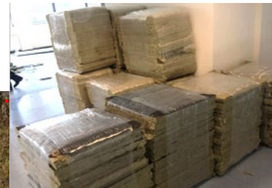
Collecte et stockage d'isolant en vue du réemploi
