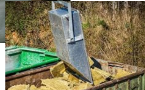
Collecte et stockage d'isolant en vue du réemploi
