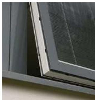
**Figure 52 - protection solaire intégrée non ventilée**
