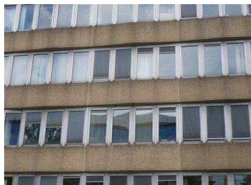
**Figure 43 – Elévation de façades en panneaux sandwichs : de type allèges portantes**
