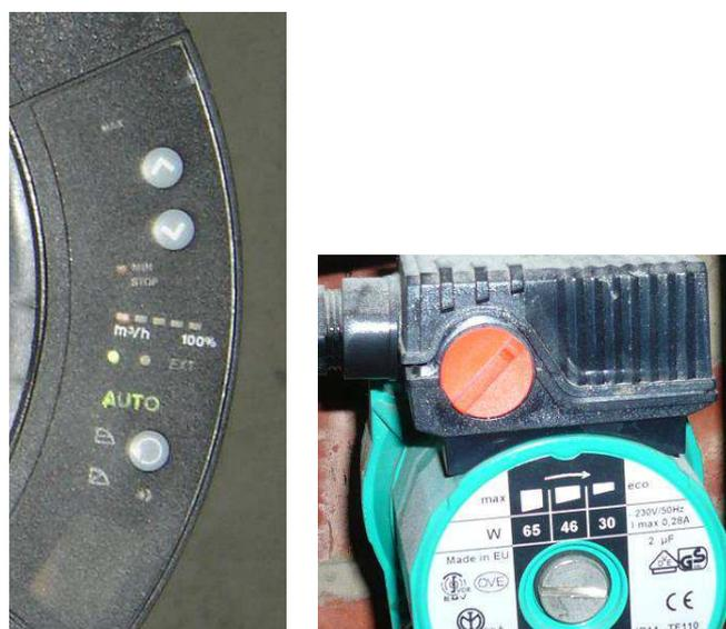
Figure 92 – Gros plans sur : à gauche un circulateur à vitesse variable, à droite un circulateur simple (avec sélecteur à 3 vitesses)
