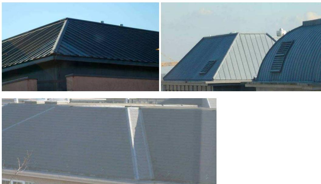
**Figure 24 - exemples de toitures inclinées de type traditionnel (ici couvertures métalliques ou en ardoises)**
