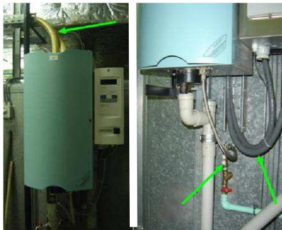
**Figure 82 - humidificateur vapeur autonome –chauffage par résistances électriques (à gauche les tuyaux de vapeur, à droite l'arrivée d'eau froide et le câble électrique de section respectable)**
