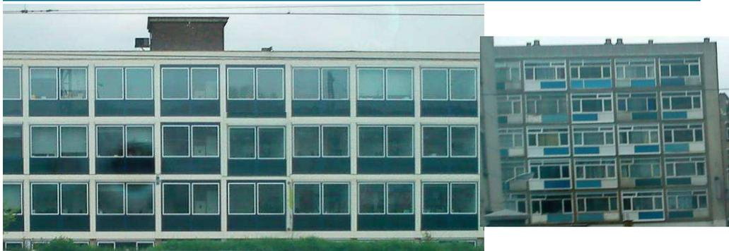
**Figure 36 - Eléments de remplissage de façades panneaux – couplés à du simple vitrage : sous-type iii**
