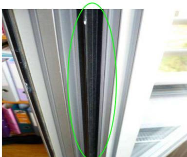
Figure 50 - rupture thermique sur le contour de l'ouvrant
