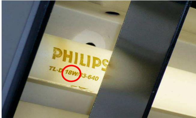
**Figure 100 Puissance d'un tube fluorescent, visible aisément. En l'occurrence ici 18 Watt**
