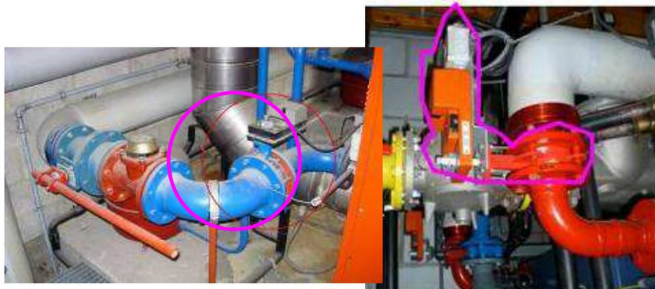
Figure 72 Exemples d'installation avec vannes automatiques d'arrêt de l'irrigation des chaudières.
