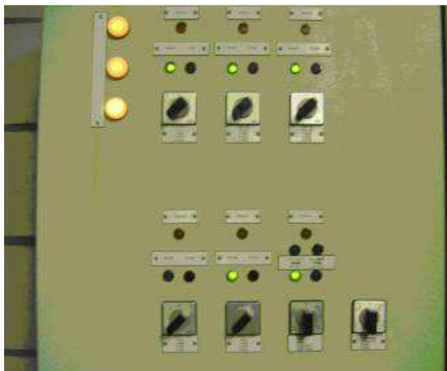
Figure 90 tableaux électrique de régulation des circulateurs
