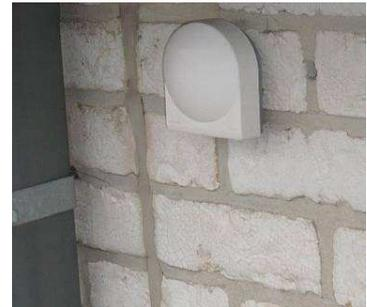
**Figure 70 - Sondes de température extérieure**
