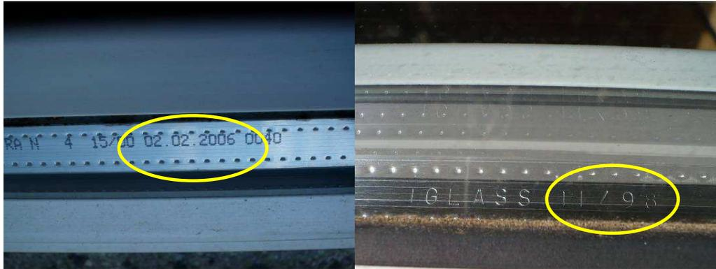
Figure 49 -Intercalaires en métal (avec la date de fabrication de la vitre)
