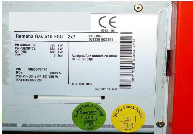
Figure 65 - plaque signalétique chaudière
