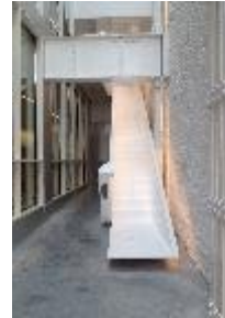
Bureaux Meusinvest Architecte Pierre Hebbelinck
