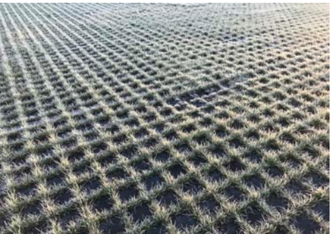
Pavage type «béton gazon»
