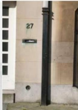
Descente d'eau de pluie apparente munie d'une souche pluviale de 1 mètre de haut minimum.
