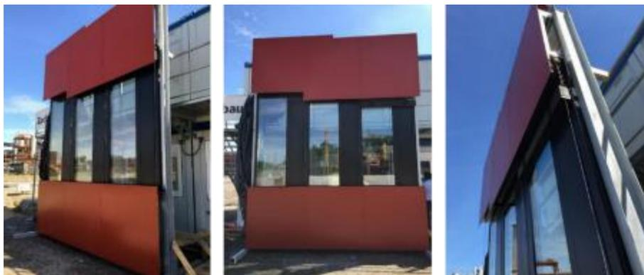
Système de façade modulaire et facilement remplaçable
