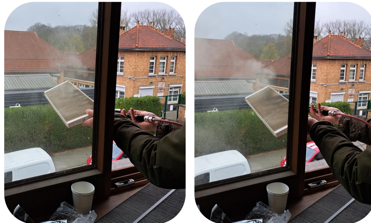
128_Gulden Bodem Nettoyage des filtres de la ventilation double flux au compresseur. La ventilation est activée en phase séchage de l'enduit argile. Les filtres sont remplacés à la fin de chantier au moment de l'emménagement des MO.
