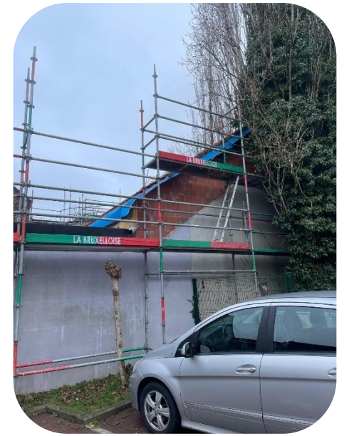
Rehausse du volume existant sur le chantier 131_Roodebeek : occupation minimale de l'espace public
