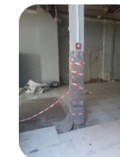
073_Poincaré Chutes de revêtement sol pour protection des colonnes
