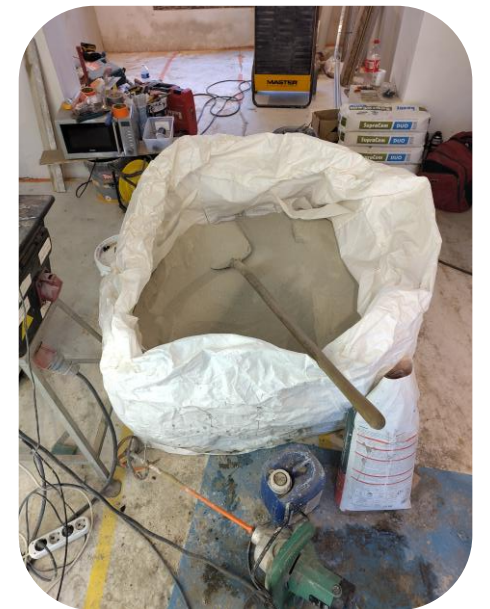
Matière brute livrée sur chantier pour la pose de l'enduit argile sur les murs, chantier 012_Thermotopie
