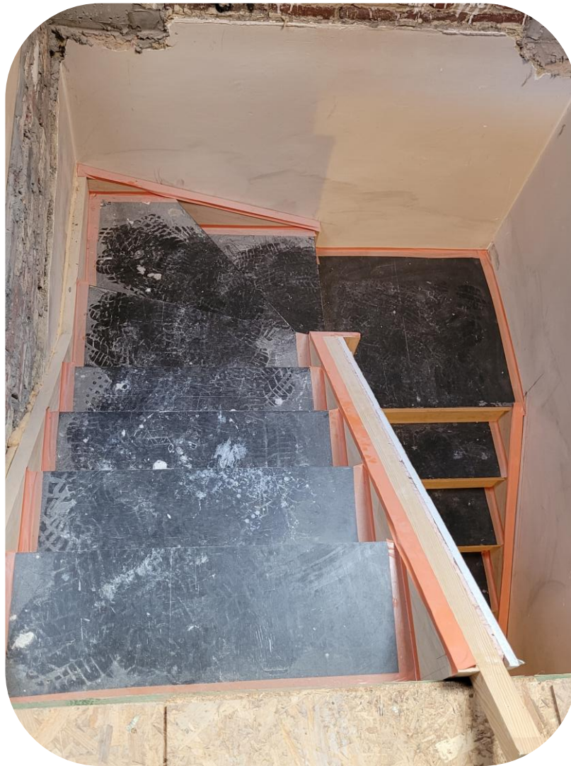
009_GROVAN Réemploi de l'ancien balatum comme protection de sol
