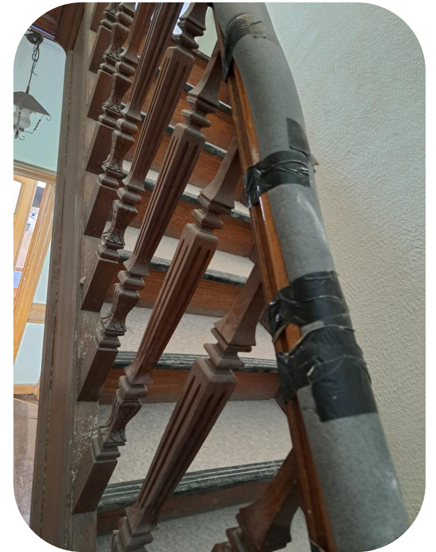
Réemploi de gaines de calorifugeage de conduites comme protection pour les rampes d'escalier 133_Bockstael 138
