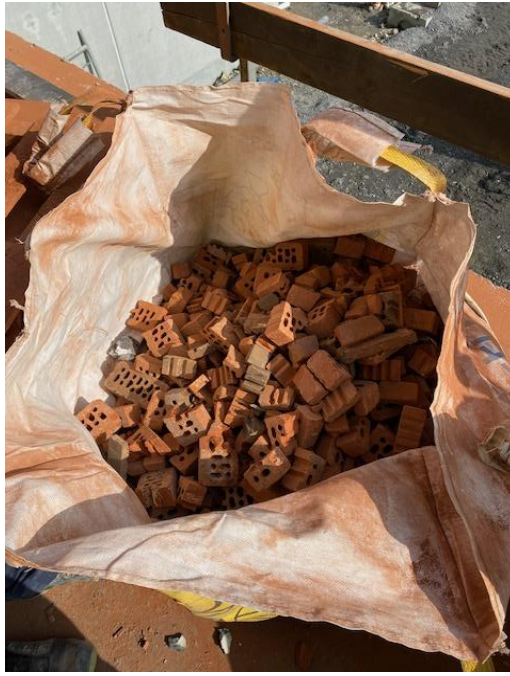
Tri prévu en big-bags: DIB, coupes de briques, mortier
