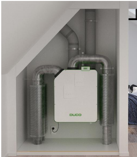
Posé au sol/mur
