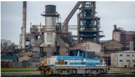
Usine de transformation de la bauxite
