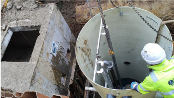
Mise en place station de pompage Kanal - Willebroek
