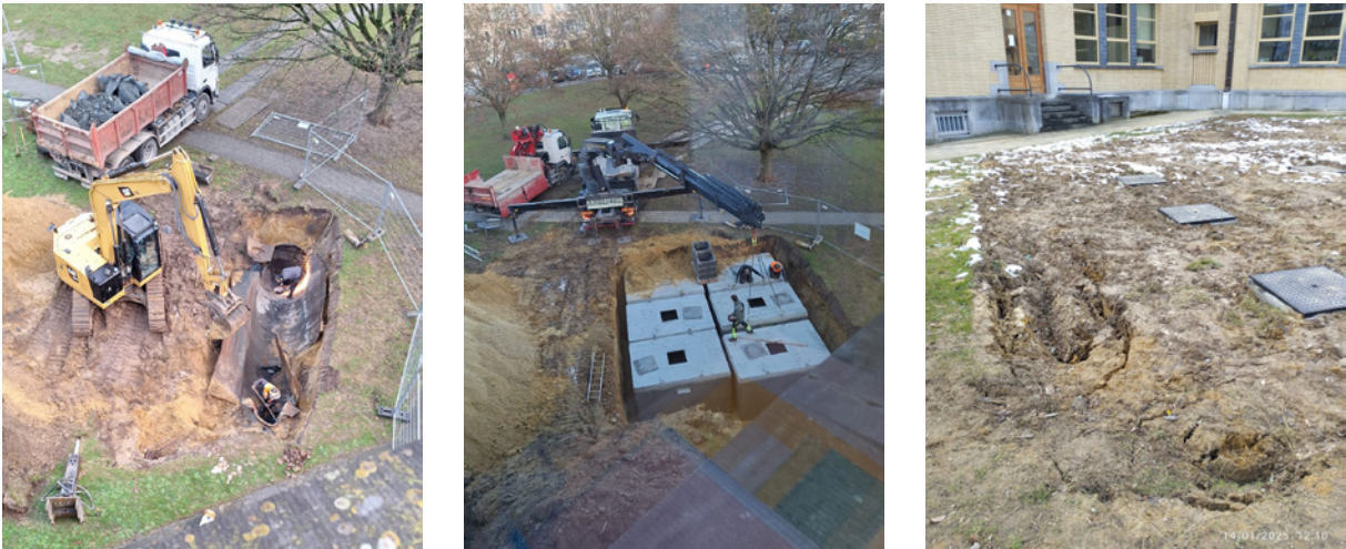
Quickwin – Déconnexion des eaux pluviales de la maison communale de Woluwe-Saint-Lambert
