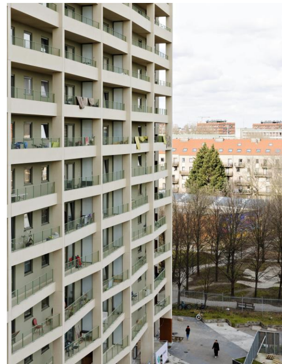
192 Goujons - Rénovation de logements sociaux
