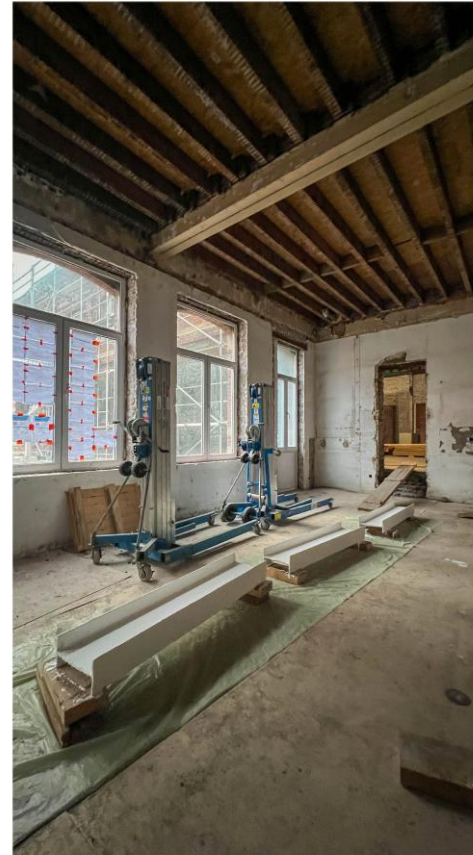
Réemploi des poutres en acier
