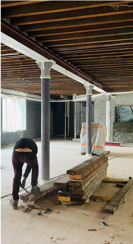
Réemploi des poutres en bois
