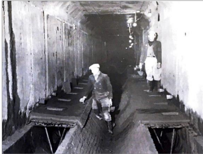
Figure 45 : Parachèvement d'une partie du voûtement de la Woluwe en 1953, (source : ASSOCIATION DE COORD., et. al., 1983 : 42)
