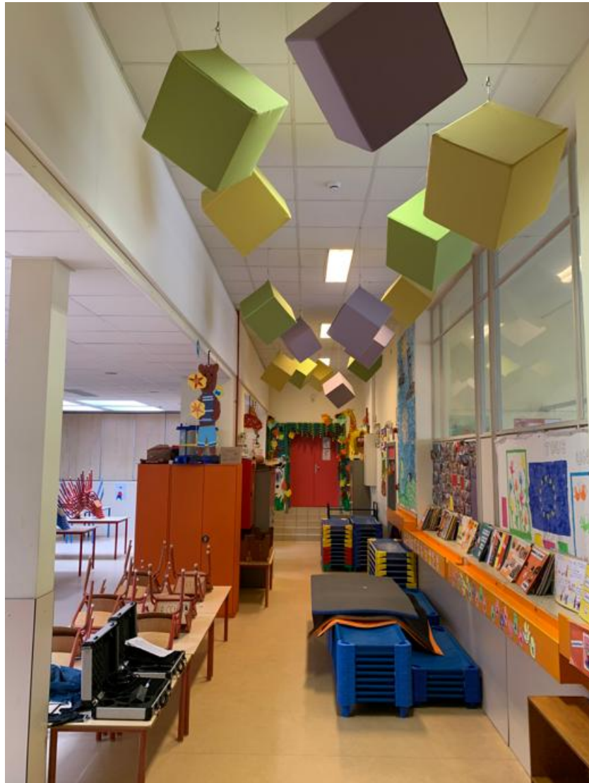
Réfectoire Ecole Van Helmont – pose d'éléments volumétriques suspendus en mousse mélamine
