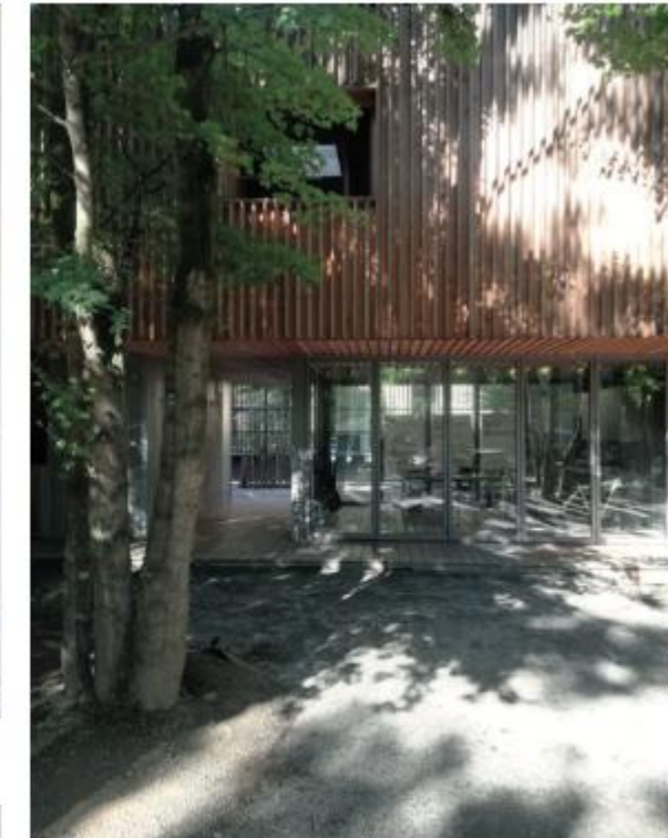
Local de quartier et sanitaires Parc Liedekerke
