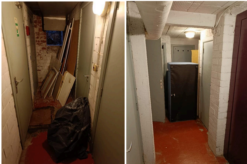
Illustration 10 : Présence d'encombrants dans les couloirs des caves
