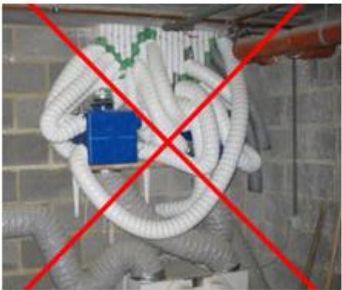
Fig. 1 Réseau de conduits pour la ventilation mécanique : un bon exemple à suivre (gauche) et un exemple de cas extrême à éviter absolument (droite).
