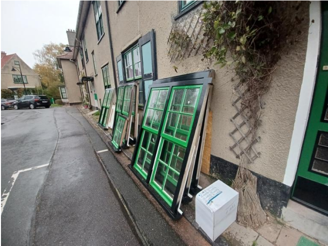
Pose ou repose des châssis restauré ou reconstitué
