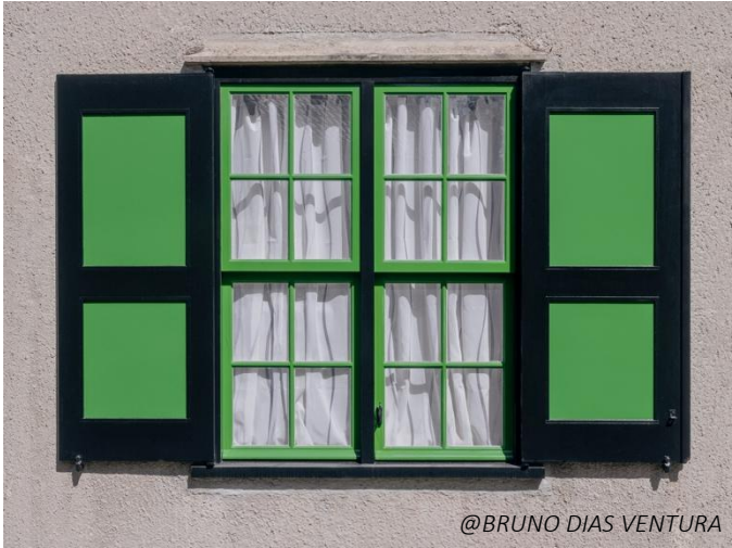
Isolation de retour de baie, retouche d'enduit tyrolien
