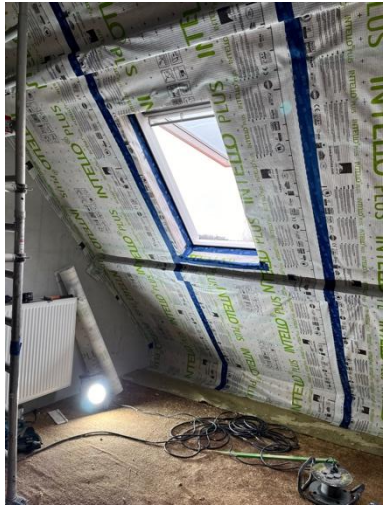
Pose du pare-vapeur du côté chaud
