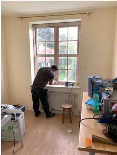
Intervention de restauration sur place
