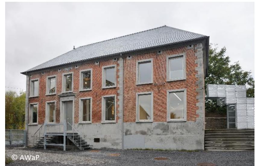
Centre des métiers de la Paix-Dieu et Pôle de la Pierre - AWAP
