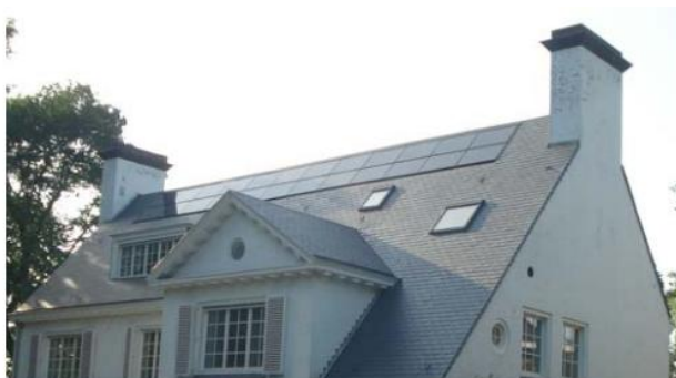
Figure 10: Modules intégrés - APERe
