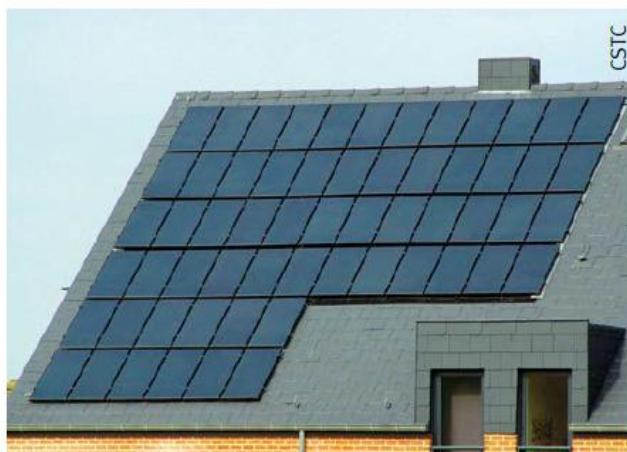
Fig. 10 Capteurs solaires photovoltaïques en semi-intégration.
