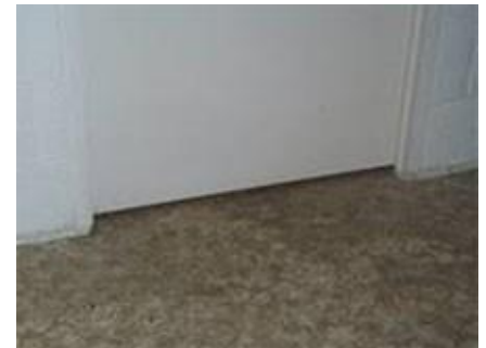
Porte détalonnée H_{\text{fente}} \geq 5 \text{ mm}
