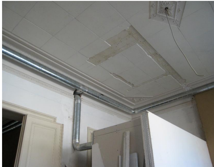
Installation des gaines de ventilation
