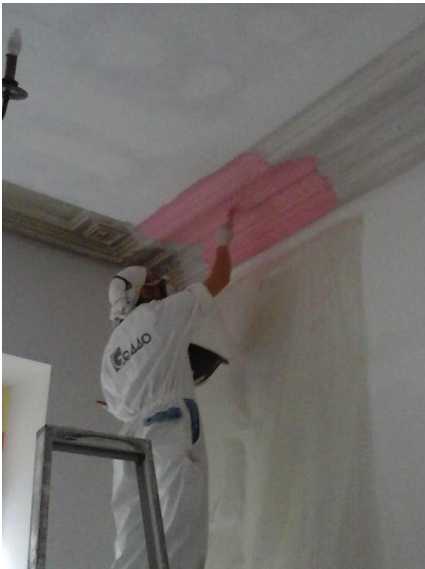
Réalisation d'un négatif de la moulure existante
