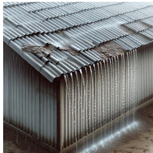
Zone d'égouttement toit en amiante (AI-generated)
