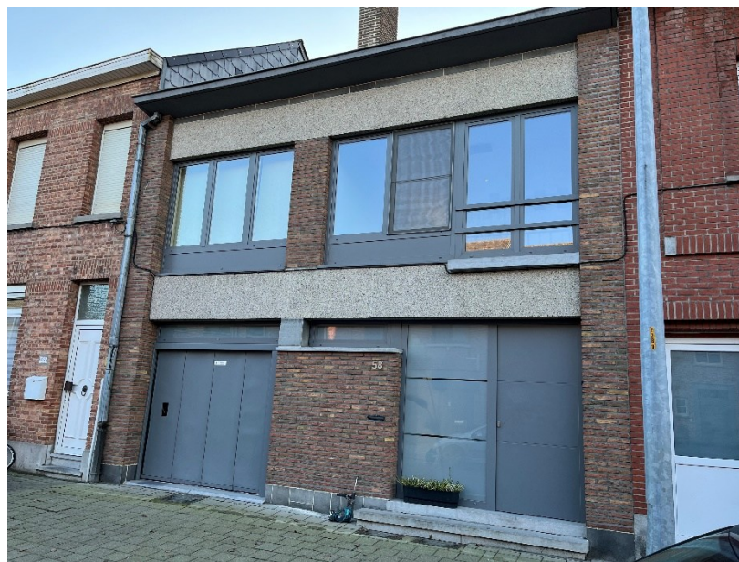
Façade sans (presque) aucun mur creux
