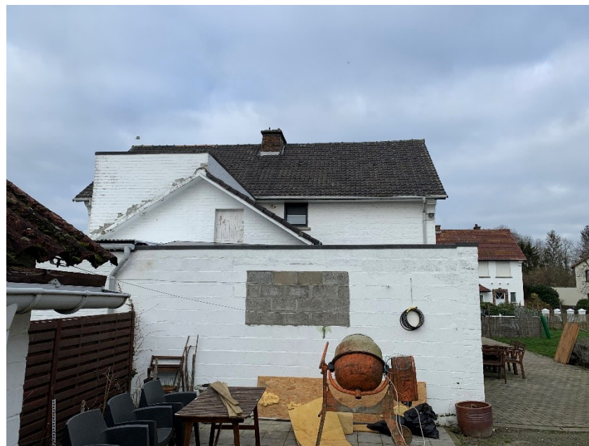
Peinture écaillée et éléments attachés
