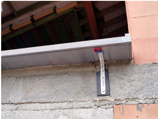
Coupure thermique seuil
