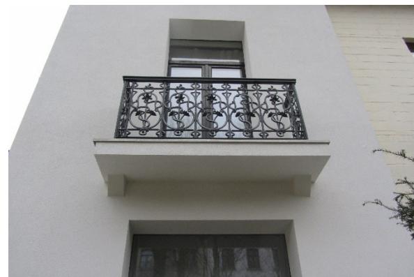
Façade avec balcon conservé - APRES
