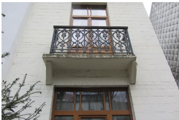
Façade avec balcon - AVANT
