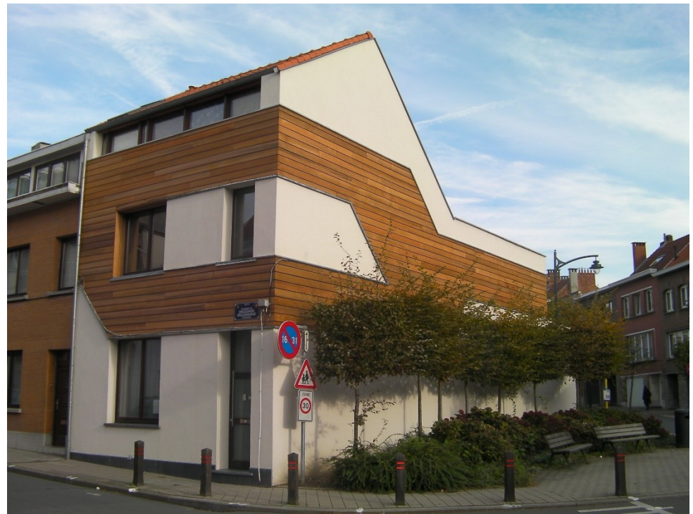
Façade à rue - APRES
