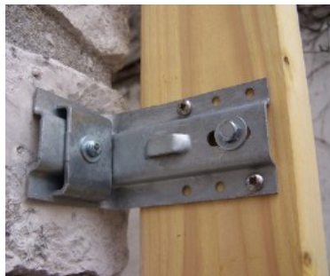
Métal traversant l'isolant
