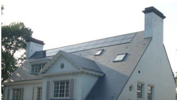
Figure 10: Modules intégrés - APERE
