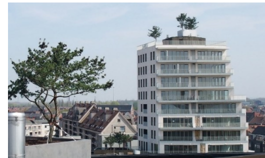
Toitures intensives à Courtrai Source: Van den Berk
