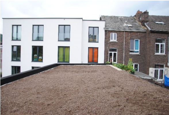
Source: écorce Toiture végétale du bureau écorce 30/08/2017
