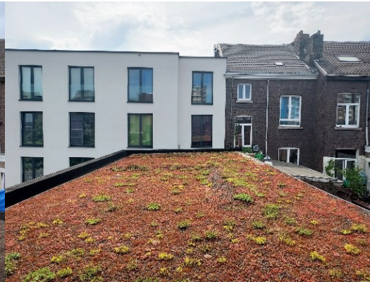
Source: écorce Toiture végétale du bureau écorce 22/06/2022
