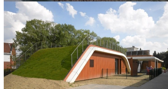
Projet crèche n°9 – A2M Source: Guide Bâtiment Durable
