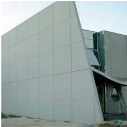
Voile béton armé
