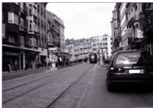
Site propre pour tram, Etterbeek
