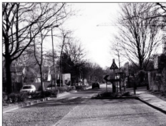
Dévoirement simple avec décalage à gauche, Rue Grands Prix, Woluwé-St-Pierre.
