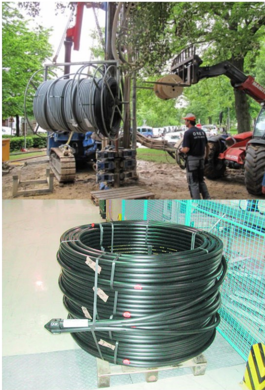
Forage & installation sonde PEHD
