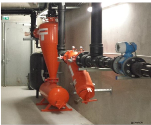
Filtre cyclonique et tamis (50 m 3 /h)
