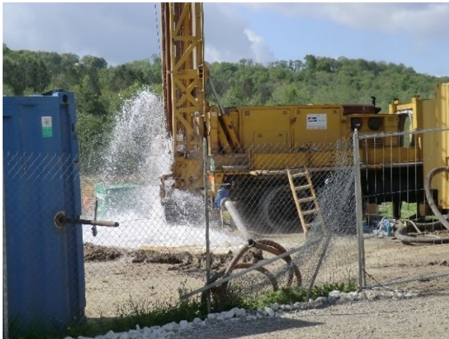
Forage du puits de production
