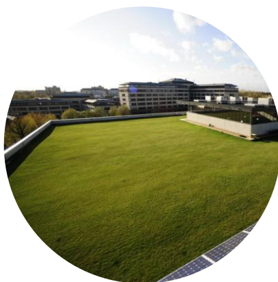
Toiture verte extensive
