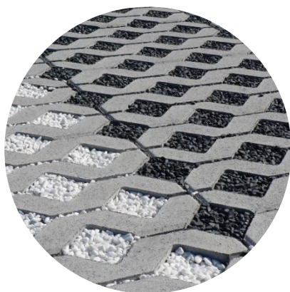
Parking en dalles béton gravillonnées
