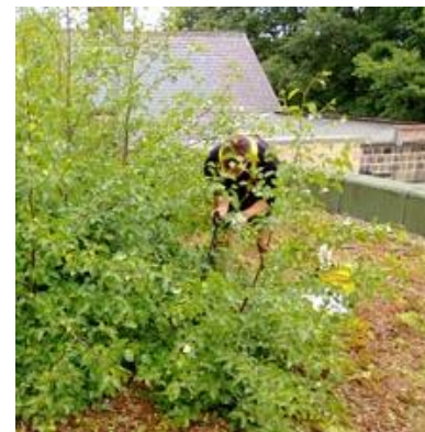
Jeunes arbres apparus sur toiture par manque d'entretien Source : turfonline.co.uk
