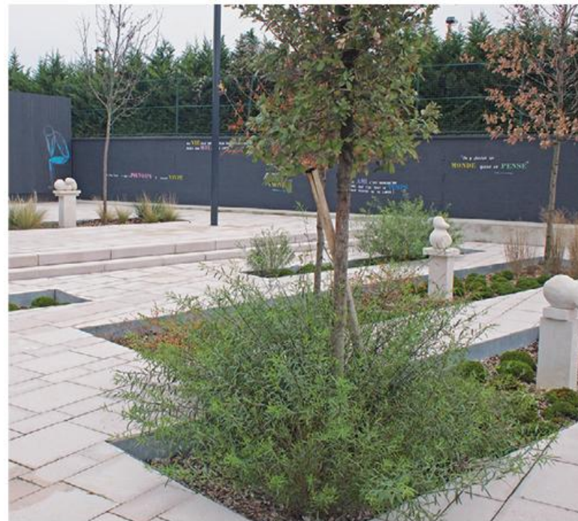
Fosse d'arbre décaissée et végétalisée, Romainville
